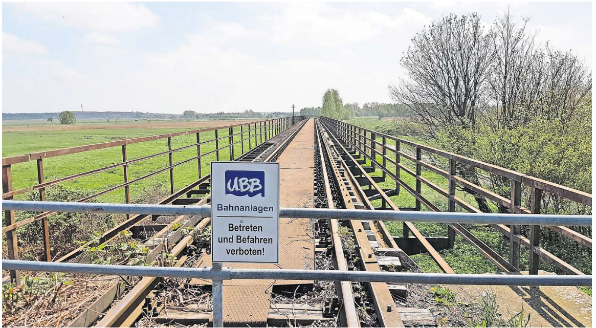
Die ehemalige Strecke der Darßbahn zwischen Prerow und Barth kurz vor der Meiningenbrücke.
