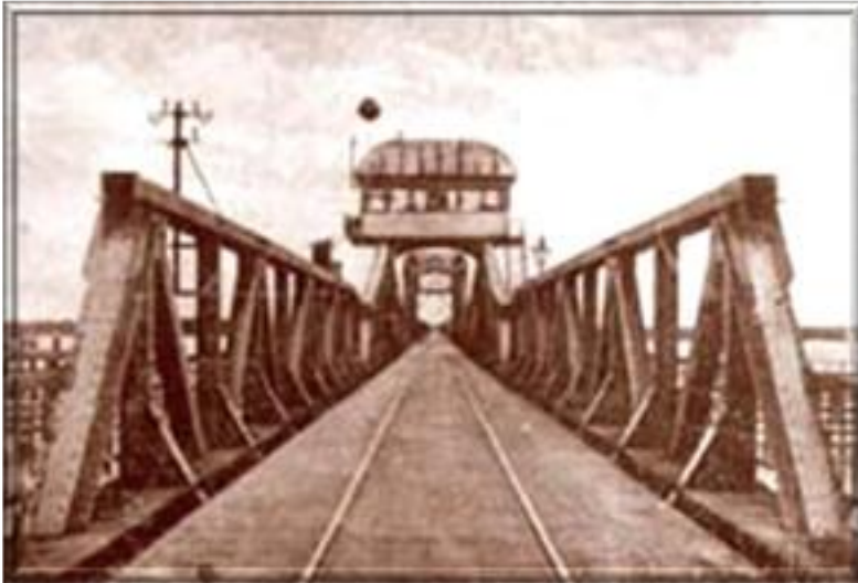
Brücke mit Gleisen um 1910
