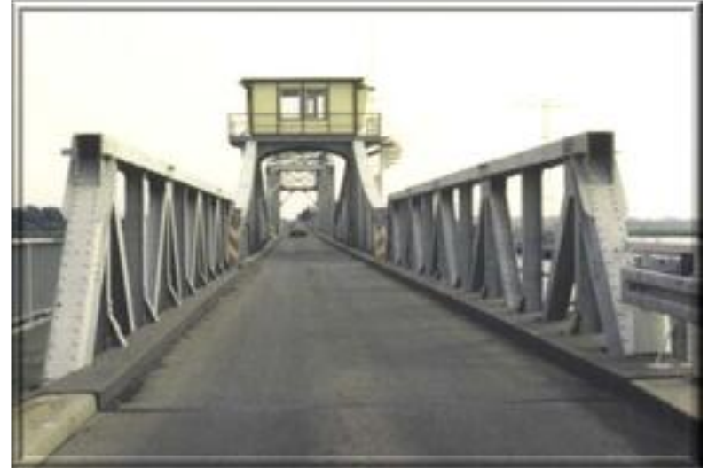
Brücke ohne Gleise nach dem Umbau
